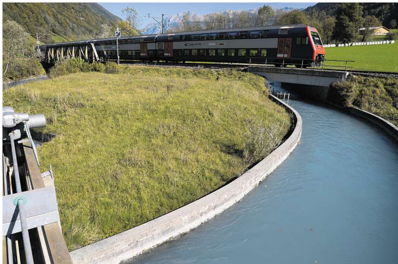
Parallel-Kraftwerk: Der Oberwasserkanal des Hefti-Hätzingen-Kraftwerks bekommt einen Druckrohr-Bypass. Bild Fridolin Rast
